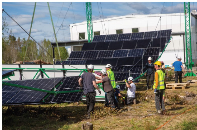
Här syns hur den unika solcellsstrukturen tar form i Glava.
